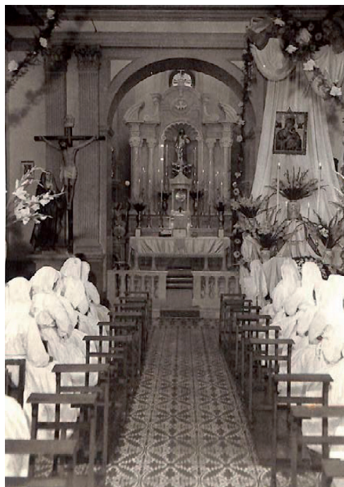
Figura 69 Capilla del Hospital de la Trinidad, circa 1930.
